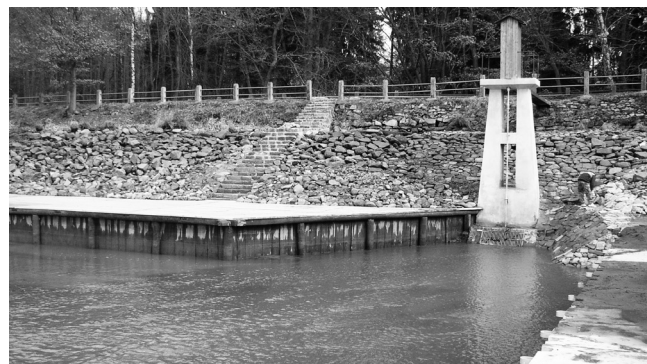
Oprava rybolovného zařízení – rybník Vyžlovský foto Pavel Kameš, ŠLP Kostelec n. Č. I.
